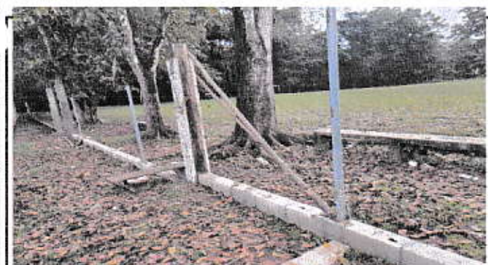
Foto 5: Fundición de postes de cemento para refuerzo de la malla metálica.
