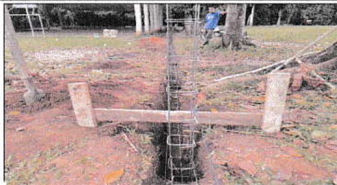
Foto1: Fundiendo columnas para portones
