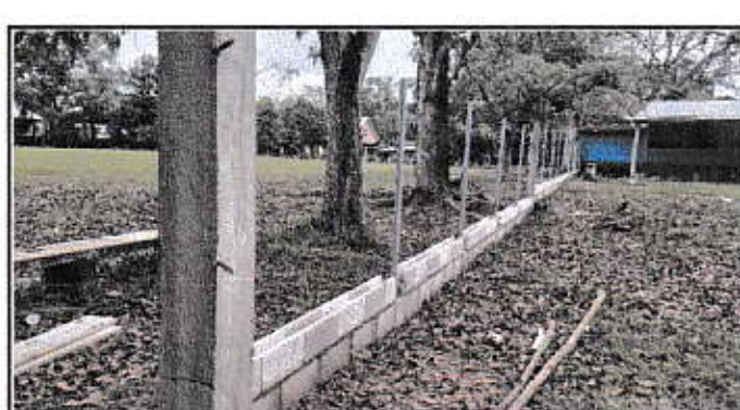
Foto 6: Colocación de bloch u para la fundición de la malla.
