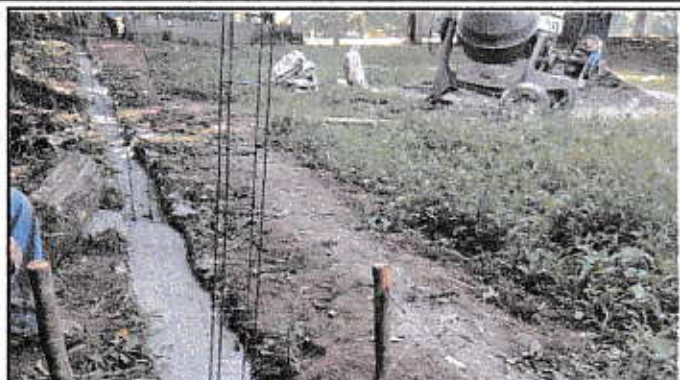
Foto 2: Fundiendo solera para colocar el block.
