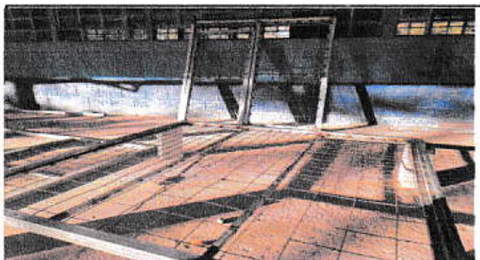
Foto 3: Elaboración de portones metálicos.
