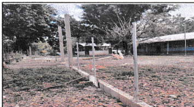
Foto 4: Colocación de primera fila de block sobre la solera y fundición de postes de tubo de cerca metálica.
